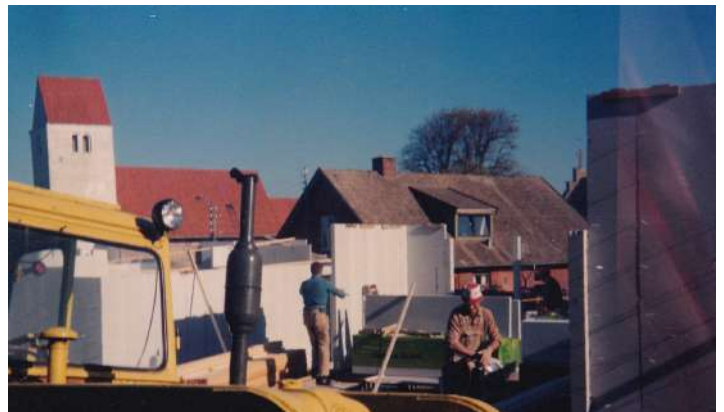
De 4 rækkehuse er påbegyndt, Østerbro 2
